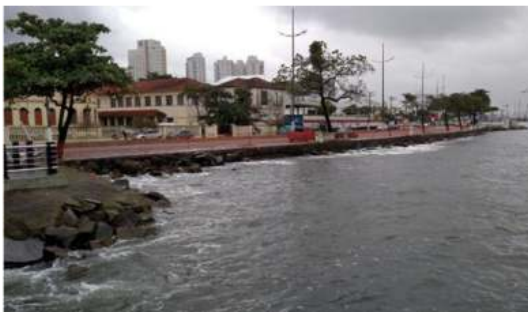
Figura 20. Muro de praia em pedra argamassada combinado com enrocamentos, Santos, São Paulo - Brasil.
