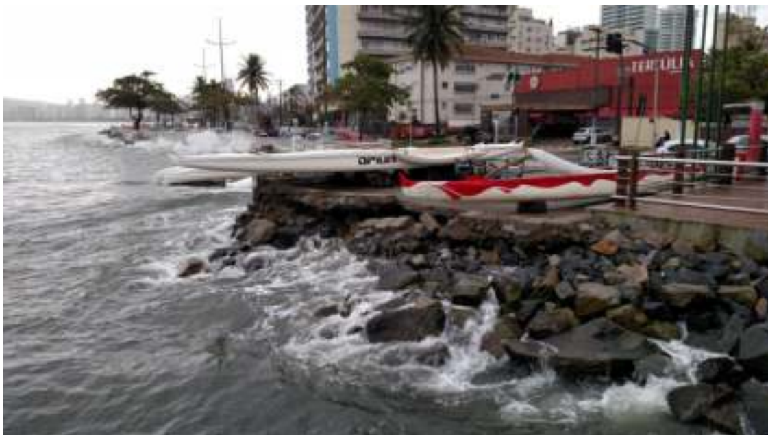
Figura 22. Revestimento em enrocamento para complementar o muro de praia em pedra argamassada, Santos, São Paulo – Brasil. Fonte: acervo pessoal, junho, 2016.
