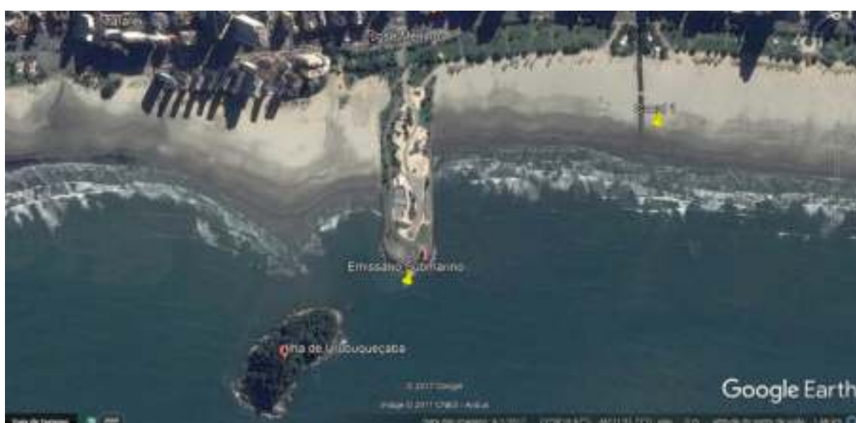
Figura 39. Vista aérea da plataforma do Emissário Submarino e da Ilha de Urubuqueçaba. Fonte: Google Earth, ©2015 Google Inc.
