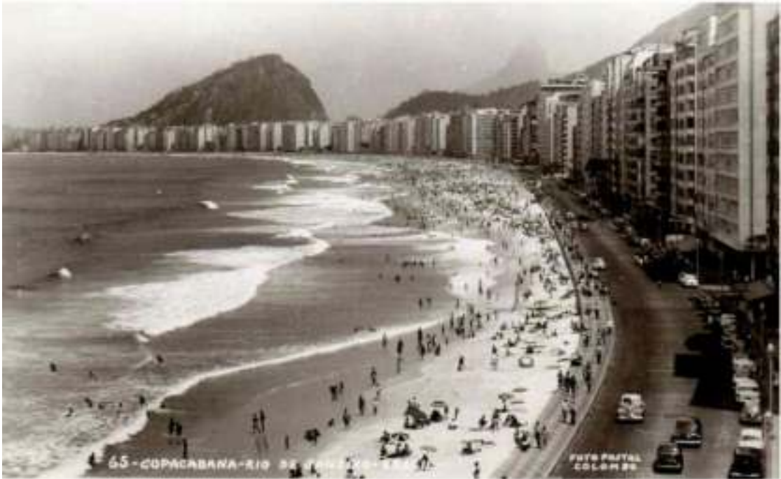
Figura 28. Praia de Copacabana, Rio de Janeiro – Brasil, antes da alimentação artificial de praia. Fonte: Foto Postal Colombo, 1965. 5
