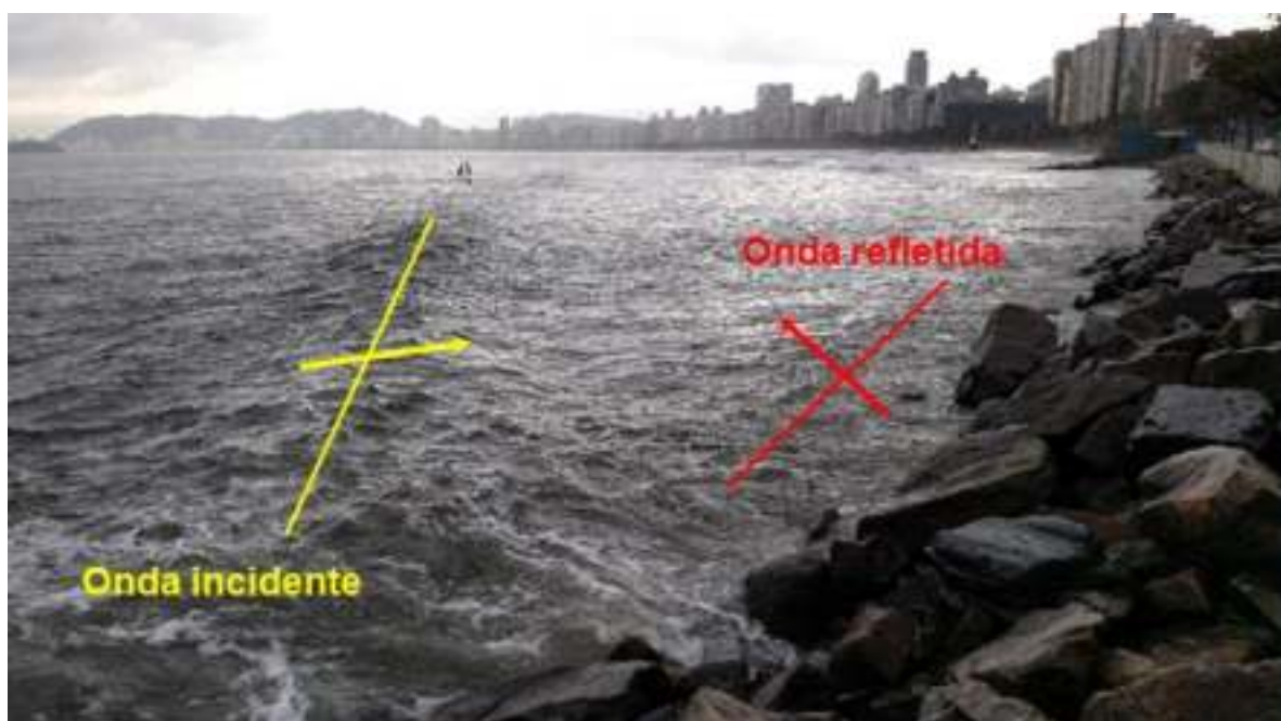
Figura 4. Reflexão de ondas devido à presença de obras de proteção costeira em Santos, São Paulo - Brasil.
