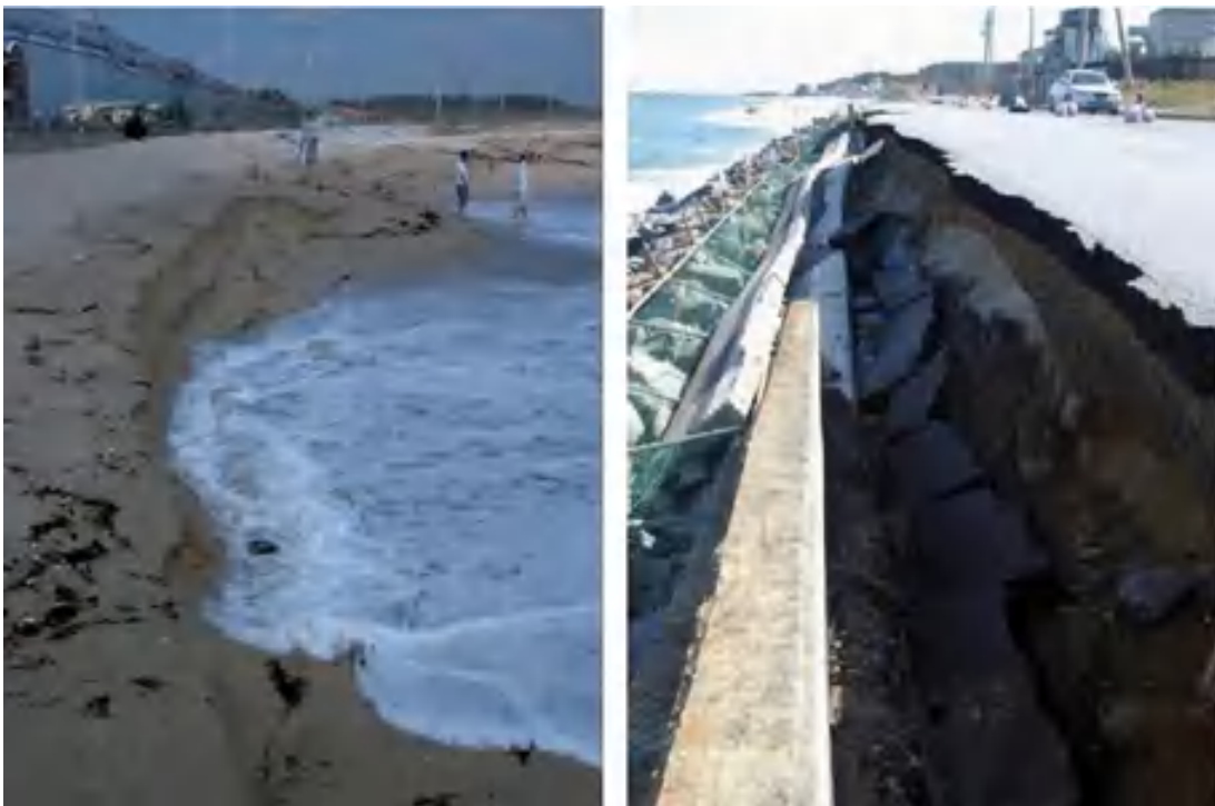
Figura 9. Efeitos da erosão na praia de Young-Jin, na Coreia do Sul. À esquerda tem-se uma imagem da erosão da costa e à direita uma estrada costeira destruída. Fonte: Adaptado de Oh e Shin, 2006.
