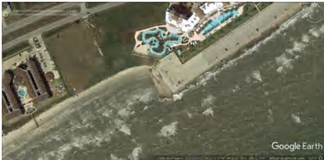
Figura 4. Extremo oeste do muro de Galveston (Texas, EUA) onde é possível ver a continuação dos processos erosivos na praia adjacente, bem como a ausência de praia ao pé do muro, 21 mar. 2018. Fonte: Google Earth, ©2015 Google Inc.
