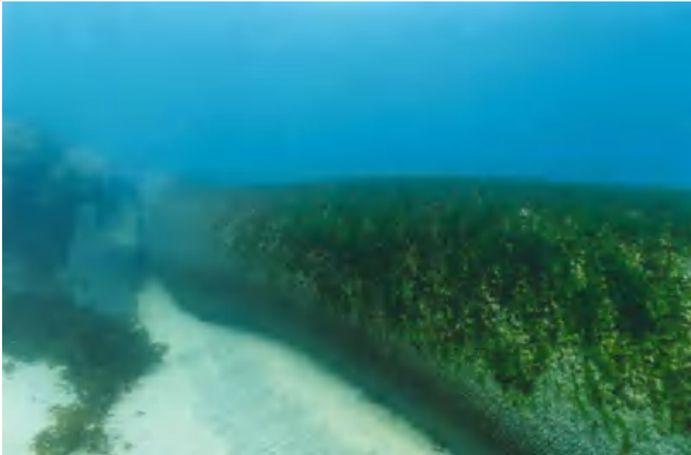
Figura 13. Algas marinhas na superfície do tubo de geotêxtil. Fonte: Oh e Shin, 2006.
