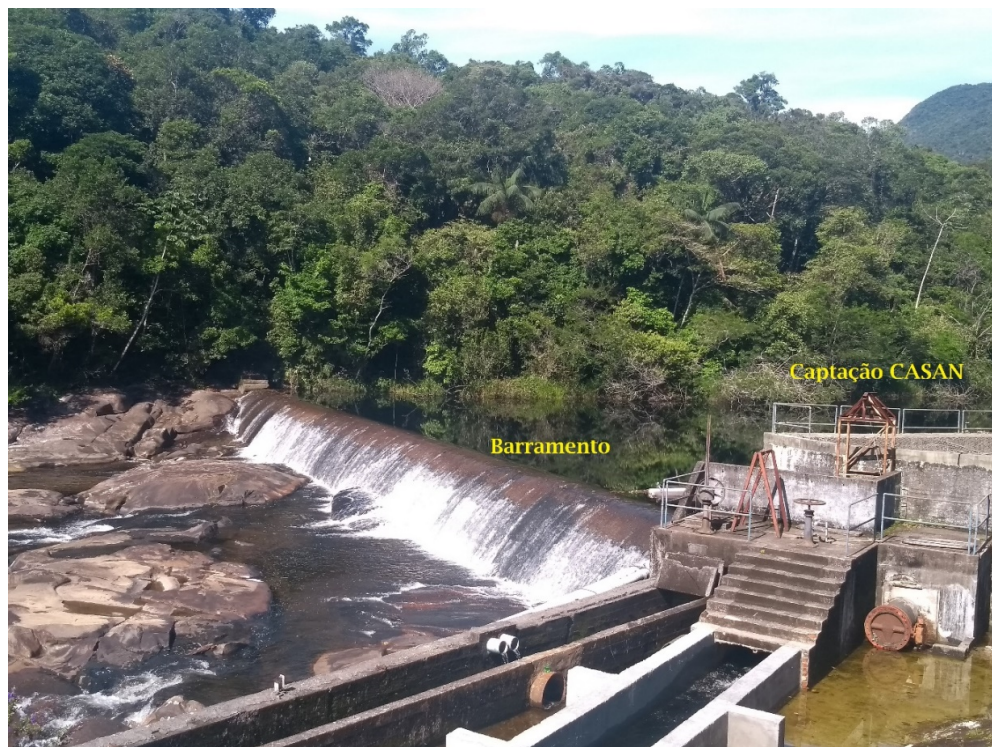
Figura 2 - Ponto de captação de água da CASAN na Represa de Pilões, no rio Vargem do Braço, no Município de Santo Amaro da Imperatriz, Santa Catarina.
